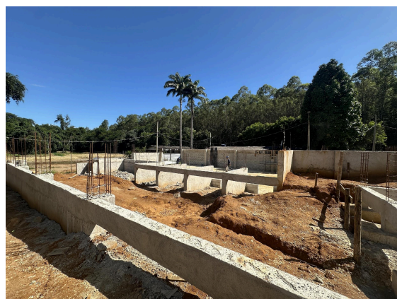
Alvenaria e contenção da passagem de caminhões Autoria: Thaís Calhau Data: 27/03/2026
