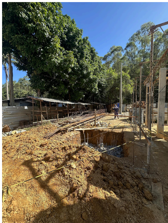
Área externa ao anexo Autoria: Thaís Calhau Data: 27/03/2026
