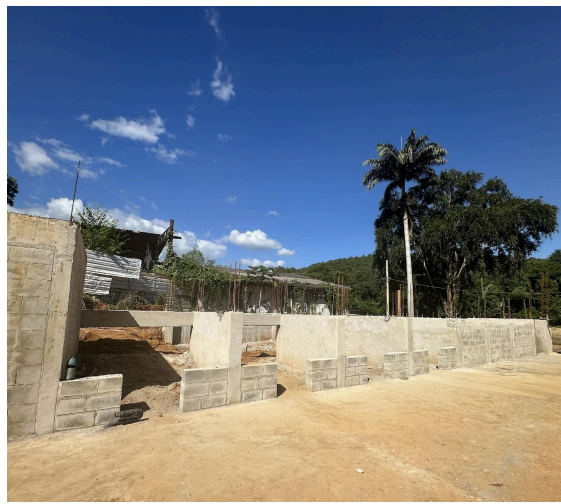
Contenções da lateral do galpão Autoria: Thaís Calhau Data: 27/03/2026
