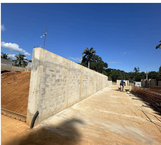
Contenção e piso de concreto do galpão Autoria: Thaís Calhau Data: 27/03/2026
