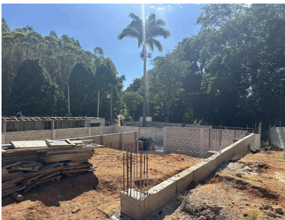
Alvenaria e contenção da passagem de caminhões Autoria: Thaís Calhau Data: 27/03/2026
